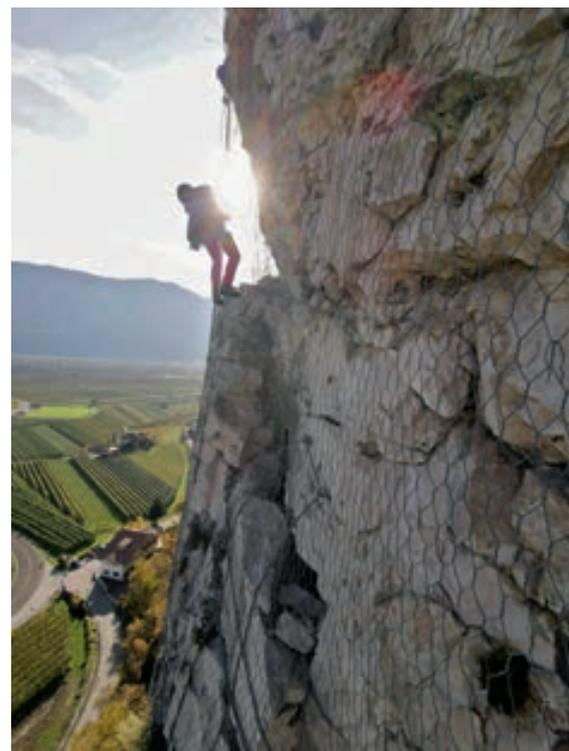
wände von losem Gesteinsmaterial. Außerdem ist die Erweiterung der Schutznetze und die Errichtung eines Schutzzaunes vorgesehen. Nicht zuletzt ist es wichtig, die gefährlichen Bereiche und die bestehenden Schutzbauwerke periodisch zu warten.
